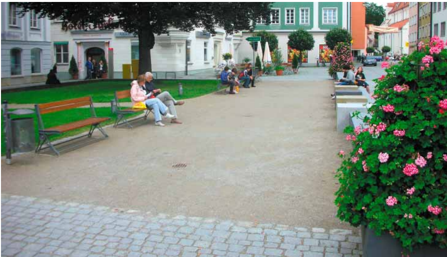
Kempten Rathausplatz nach erfolgreicher Sanierung von Teilbereichen mit einer Bindemittel-Decke.
