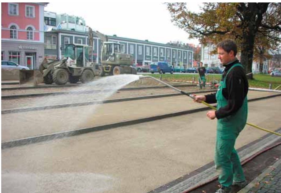
Schritt 3: Nach einem ersten Vorwalzen: durchdringendes Wässern.
