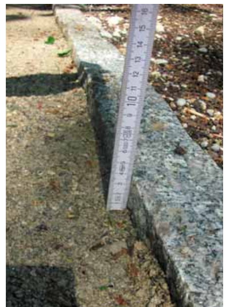
Schritt 1: Einige wichtige Schritte beim Einbau einer Bindemittel-Decke: saubere Tragschichtprofilierung.
