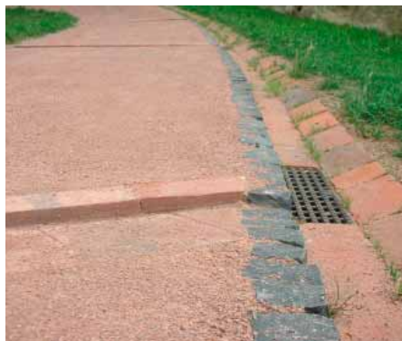
Vorbildliche Anordnung von Querrinnen an einem Steilweg mit Bindemittel-Wegedecke (am Zugang zur Heldburg in Thüringen). Statt der seitlichen Einläufe könnte das Wasser alternativ auch ins Gelände abgeführt werden.
