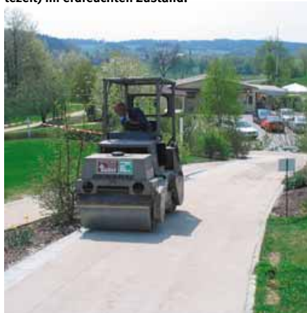
Schritt 4: Zweiter, gründlicher Walzgang (nach Wartezeit) im erdfeuchten Zustand.
